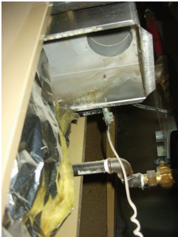
Afb. 9.21 Open toestel met trekonderbreker
