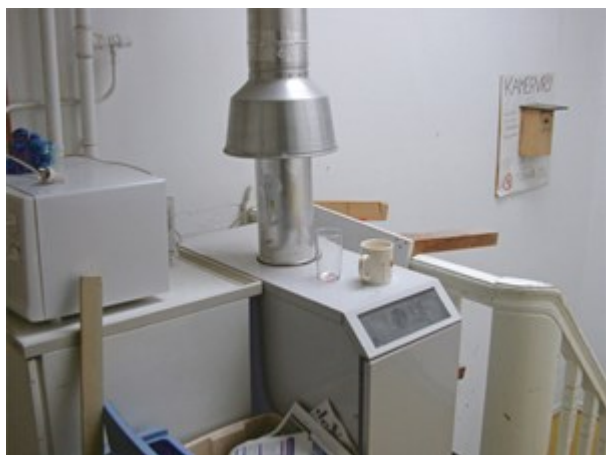
Afb. 9.19 Open toestel met trekonderbreker
