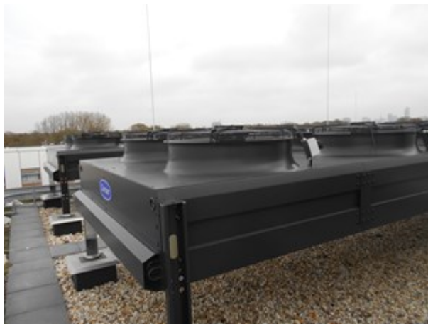
Afb. 10.12 Luchtgekoelde condensor (drycooler) (bron: Carrier)
