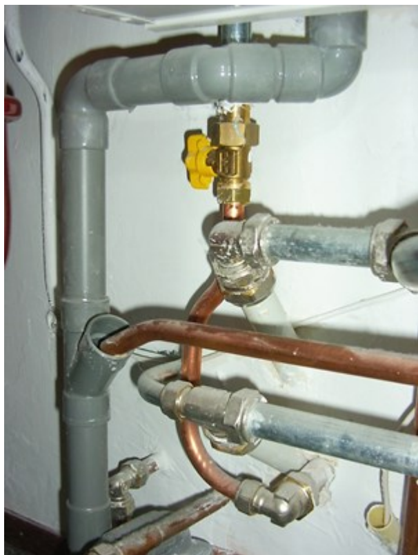
Afb. 9.16 Condensaatafvoer onder CV-ketel, kenmerkend voor HR-ketels
