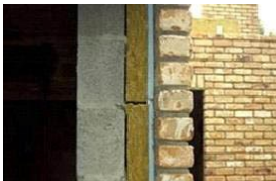
Afb. 8.38 Isolatiemateriaal sluit onderling niet goed op elkaar aan (bron: Nieman)
