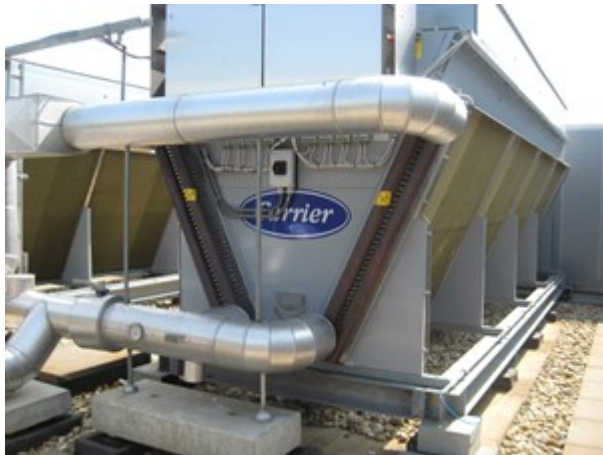
Afb. 10.13 Luchtgekoelde condensor (drycooler) (bron: Carrier)
