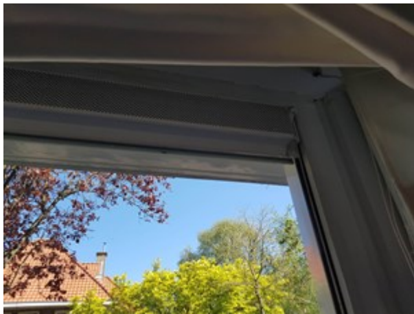
Afb. 11.4 Ventilatioerooster boven raam
