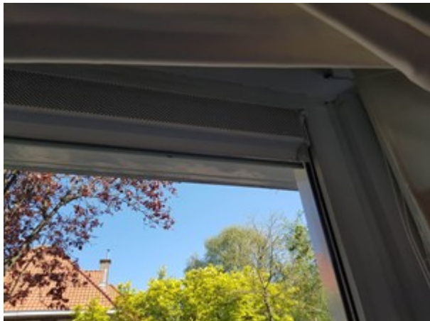
Afb. 8.15 Voorbeeld van een ventilatioerooster boven raam
