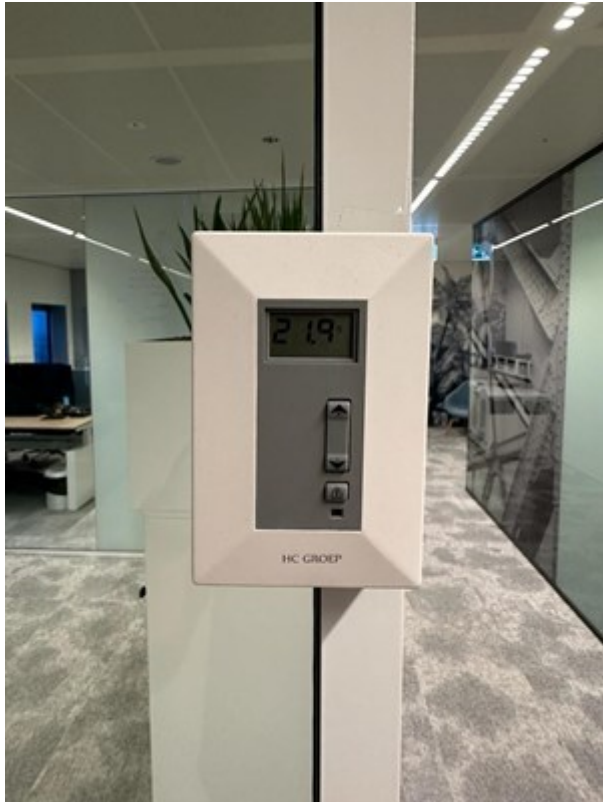
Afb. 9.82 Ruimtebedieningseenheid
