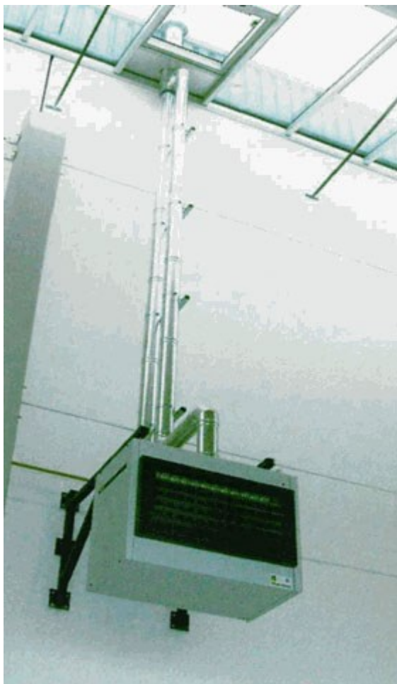
Afb. 9.23 Direct gestookte luchtverhitter
