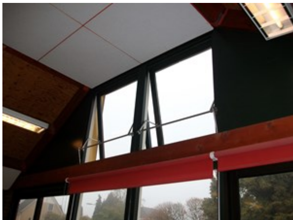
Afb. 11.6 Te openen raam voor natuurlijke luchttoevoer
