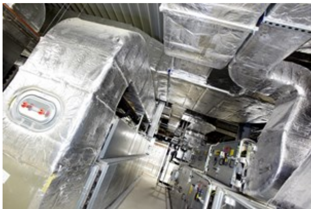
Afb. 11.58 Geïsoleerde luchtkanalen (bron: Rockwool)
